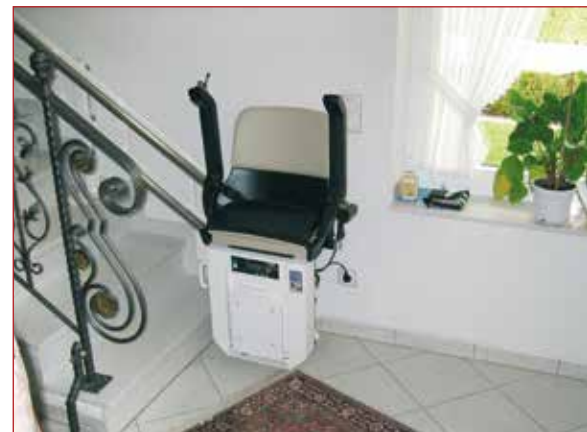
Durch Einbau eines Außenläufers bleibt das schöne Geländer ein Blickfang
