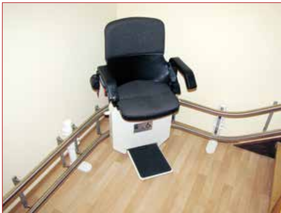
Außenläufer auf einem Treppenpodest
