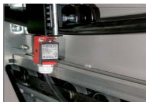
Системы безопасности – контроллер поломки поручней
