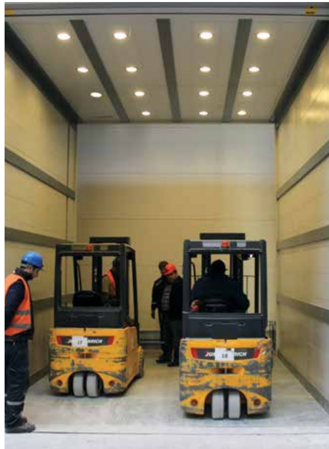
Hydraulic lift (rated load 10.000 kg) Hydraulikaufzug (Nutzlast 10.000Kg)
