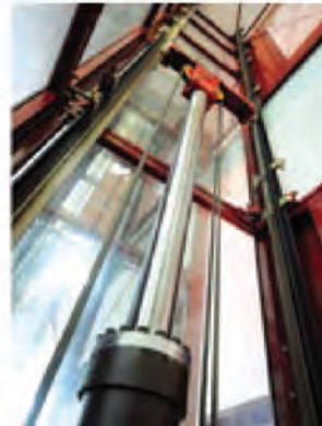
Hidrolik L karkas L Frame for hydraulic lifts Гидравлическая рама L
