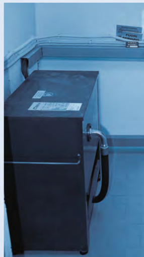
Per il serbatoio dell'olio può essere utilizzato il locale macchina. ПРОСТРАНСТВО МАШИНОГО ПОМЕЩЕНИЯ МОЖЕТ БЫТЬ ИСПОЛЬЗОВАНО ДЛЯ ДРУГИХ ЦЕЛЕЙ.
