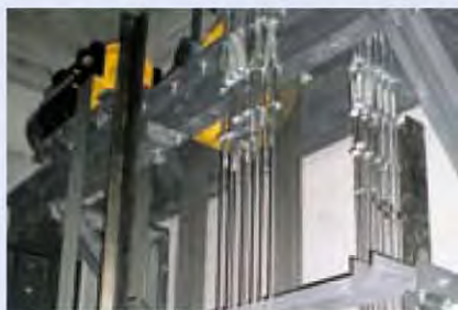
Безредукторная лебедка для лифтов грузоподъемностью до 5000 кг
