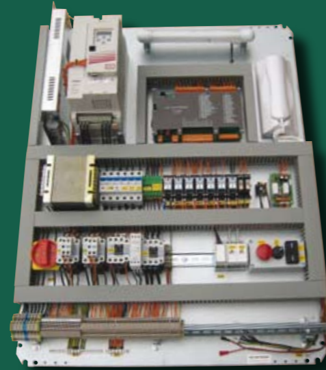
Е тип VVVF плата управления
