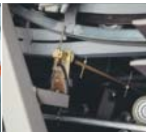
❸ Выключатель безопасности, срабатывающий при поломке ступеней
