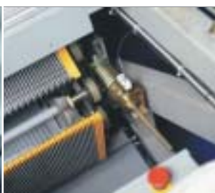
❷ Блокировка тяговых цепей ступеней эскалатора
