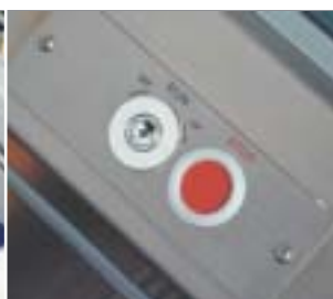
❸ Аварийный выключатель эскалатора
